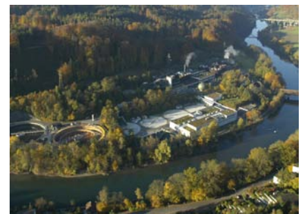
L'optimisation ciblée de certaines STEP communales permettra de réduire l'apport de micropolluants dans les eaux.
