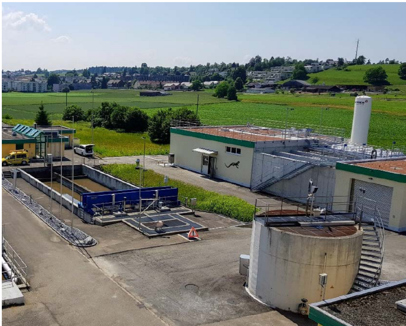
Ozonation STEP Bassersdorf, Photo: ARA Eich, Bassersdorf
